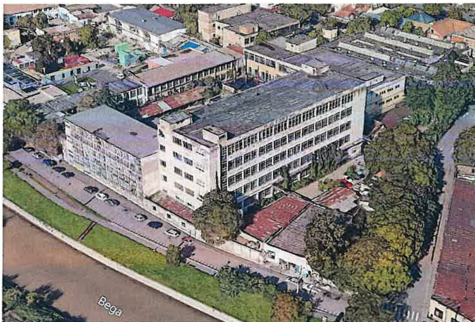
Perspectiva aeriană asupra ansamblului cu marcarea corpului A sursă Google Earth
