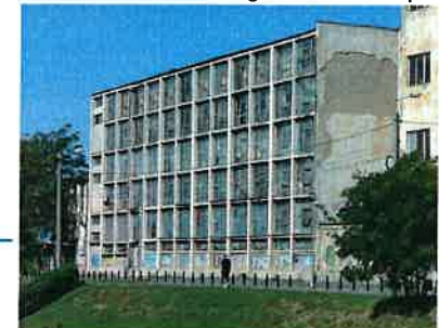
Imag. exterioară cu fațada corpului H
