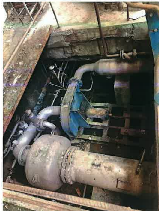
Detaliu instalații din pardosea, sursă arhive personale Dumescu Diana, 2023
