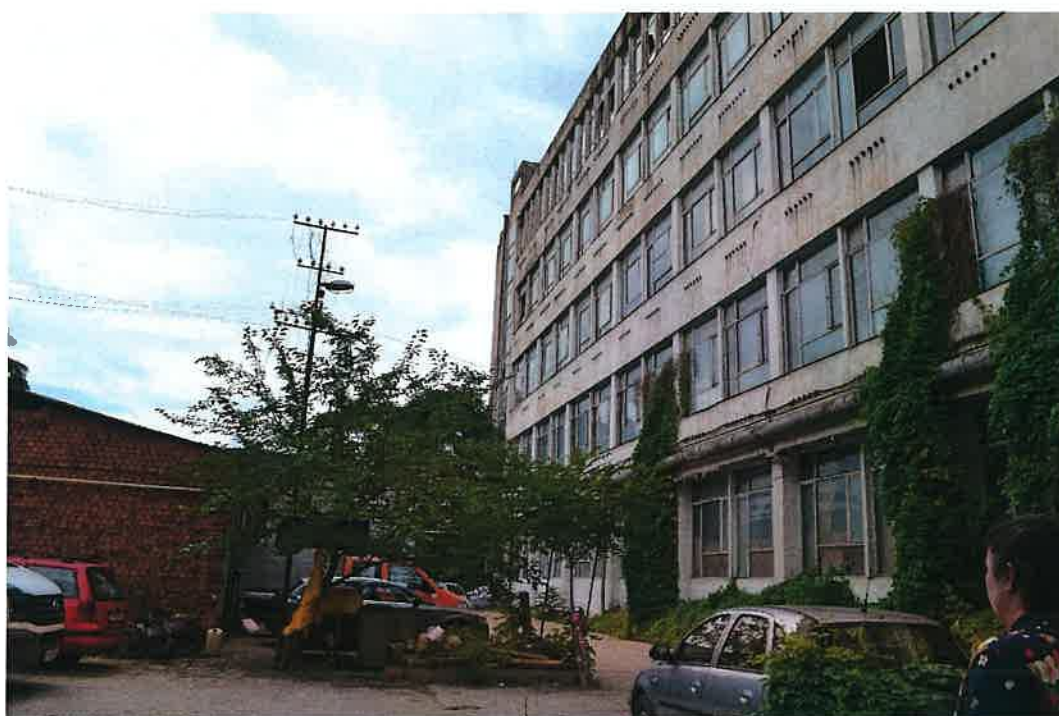
Fațadă est corp A și anexele învecinate, sursă arhive personale Bâldea Maja, 2023.
